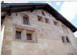
L'extérieur du château. On lui a appelé à rénover.
